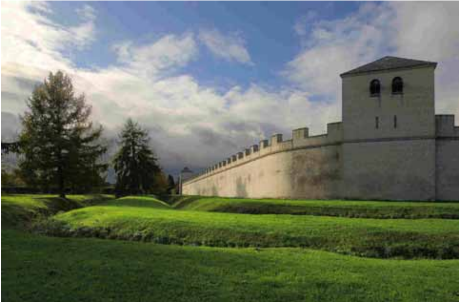
Xanten, Stadtmauer der Colonia Ulpia Traiana Foto: Axel Thünker DGPh
